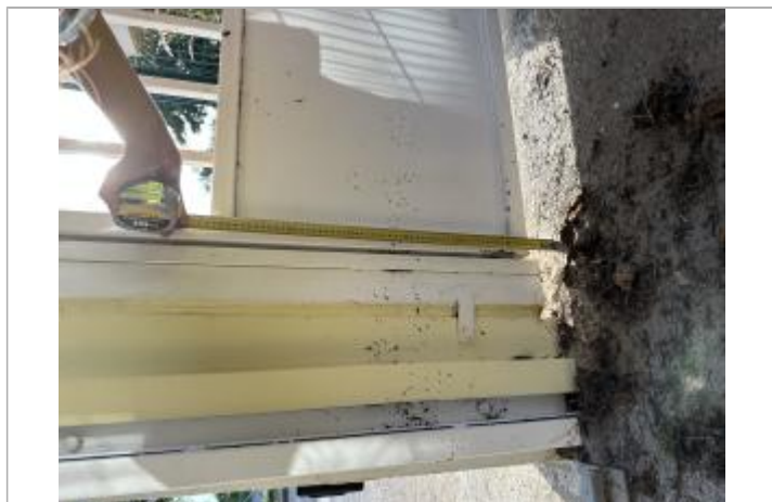
Dépôts de matières solides
