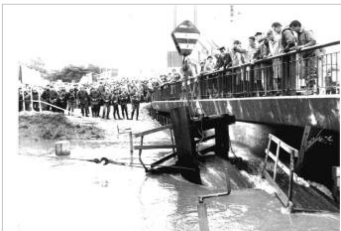
Embâcle provoqué par la porte d'écluse sous le pont de la rue Saint-Malo
