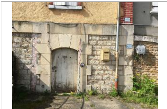
Vue du site - Auteur : DRIEE IDF
