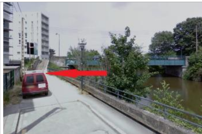
Chemin en aval rive droite du pont Villebois-Mareuil
