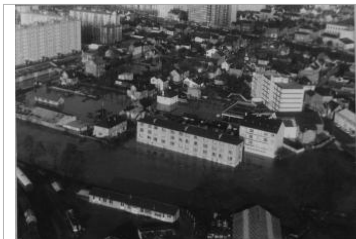
Photographie aérienne de l'inondation de novembre 1974
