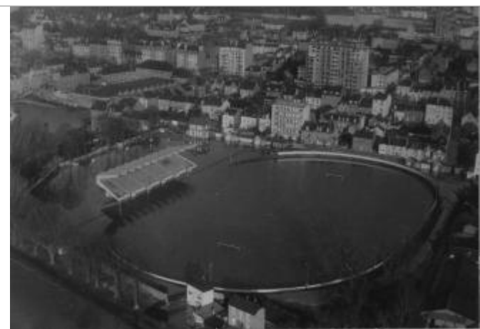
Photographie aérienne de l'inondation de novembre 1974
