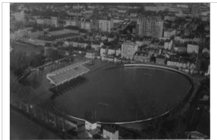
Photographie aérienne de l'inondation de novembre 1974
