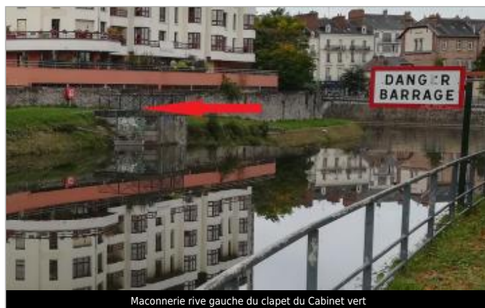
Maçonnerie rive gauche du clapet du Cabinet vert
