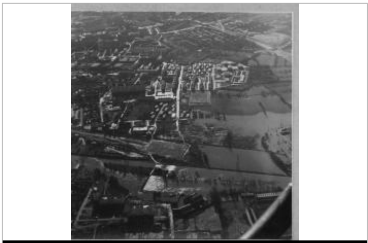
Photographie aérienne de l'inondation de novembre 1974
