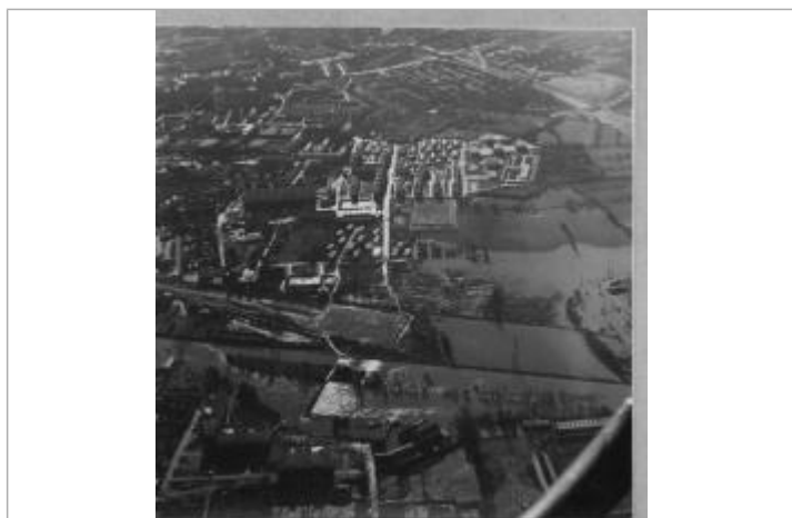
Photographie aérienne de l'inondation de novembre 1974
