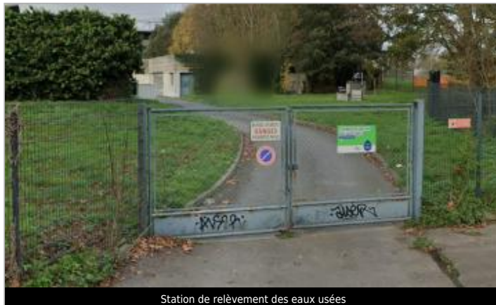
Station de relèvement des eaux usées
