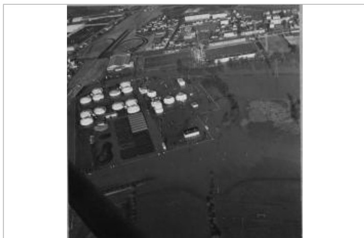
Photographie aérienne de l'inondation de novembre 1974
