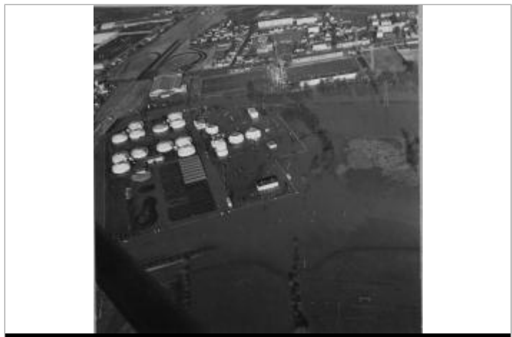
Photographie aérienne de l'inondation de novembre 1974
