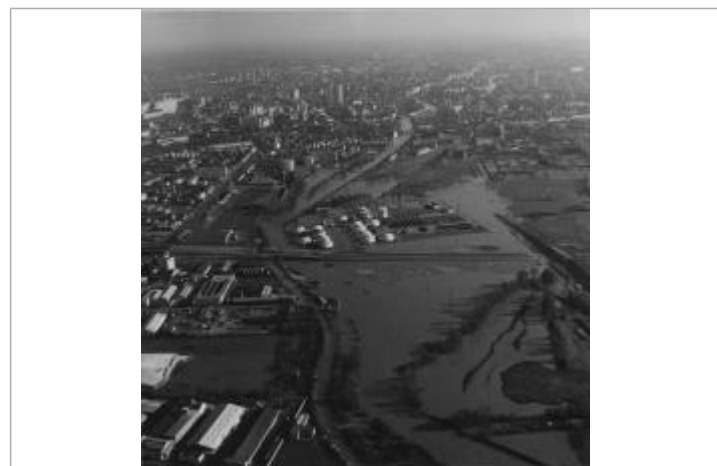
Photographie aérienne de l'inondation de novembre 1974
