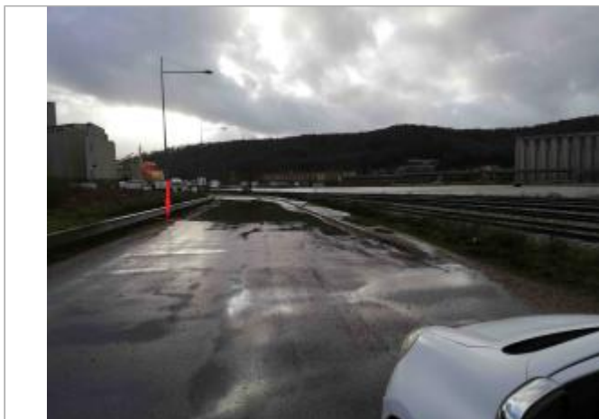
Sol de la chaussée bithumé, quai de petit Couronne.
