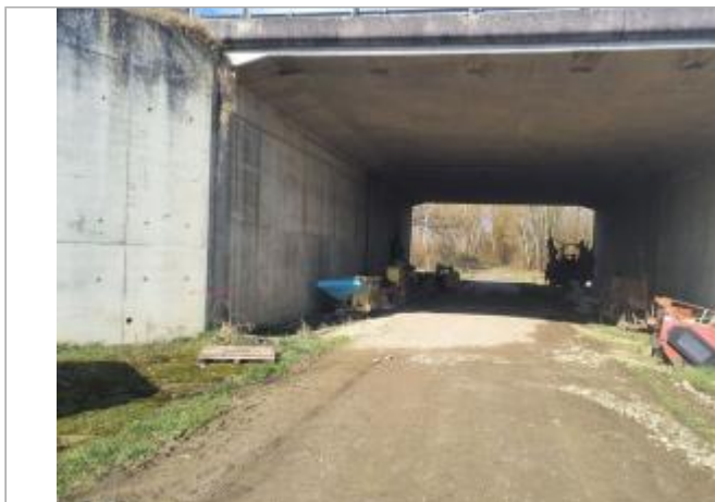
Marque sur structure Photo © AGERIN
