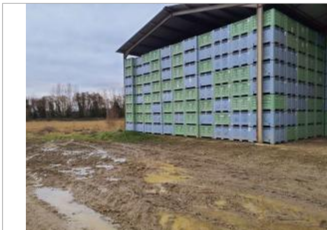
Marque sur structure Photo © AGERIN
