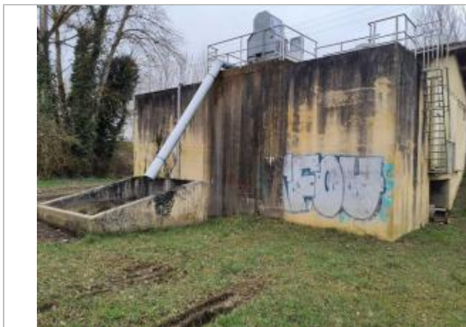
Marque sur structure Photo © AGERIN
