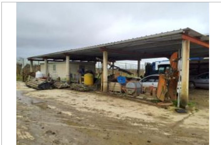
Marque sur structure Photo © AGERIN
