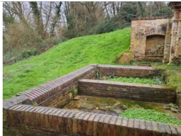
Marque sur structure Photo © AGERIN
