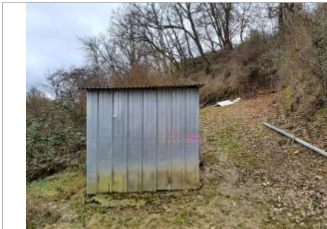
Marque sur structure Photo © AGERIN
