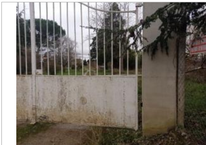
Marque sur structure Photo © AGERIN
