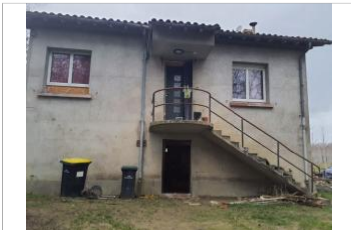
Marque sur structure Photo © AGERIN
