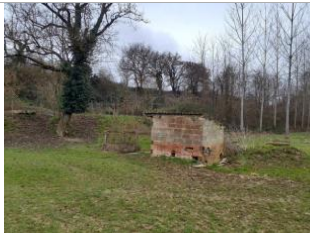
Marque sur structure Photo © AGERIN
