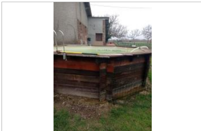
Marque sur structure Photo © AGERIN
