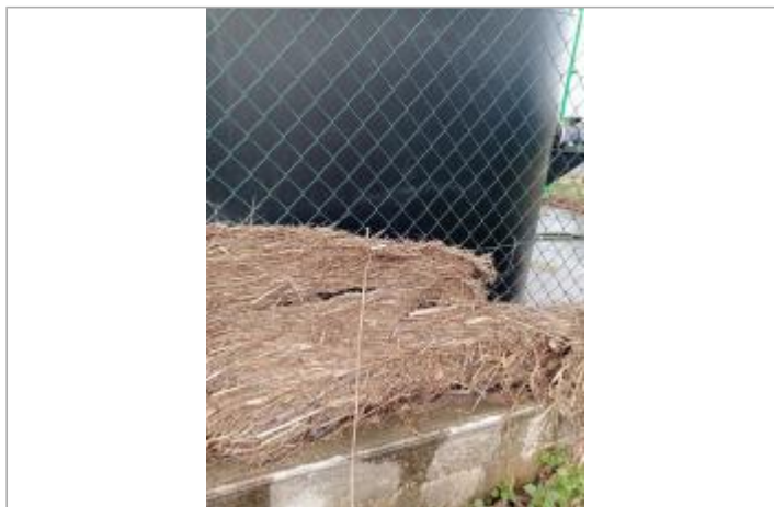
Marque sur structure Photo © AGERIN
