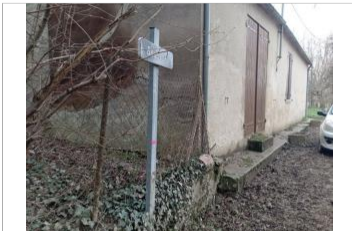
Marque sur structure Photo © AGERIN
