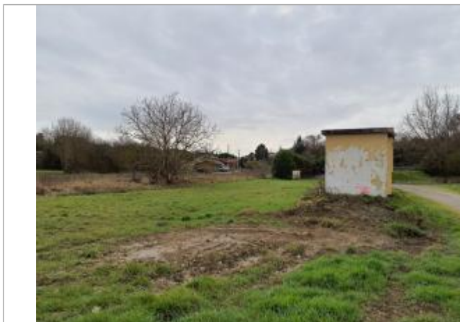
Marque sur structure Photo © AGERIN
