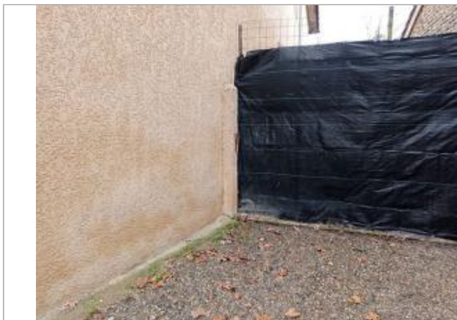
Marque sur structure Photo © AGERIN
