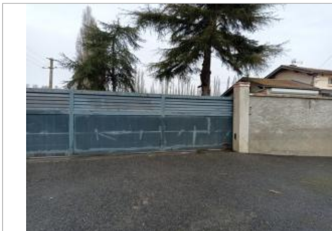
Marque sur structure Photo © AGERIN
