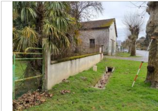
Marque sur structure Photo © AGERIN
