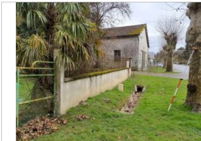
Marque sur structure Photo © AGERIN
