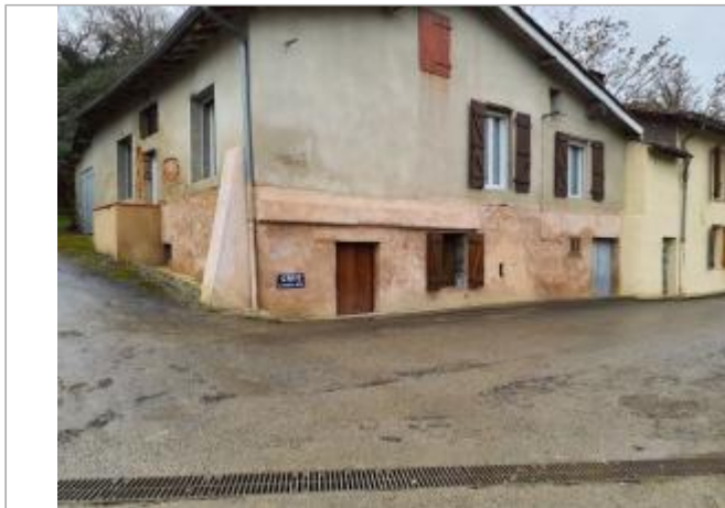
Marque sur structure Photo © AGERIN
