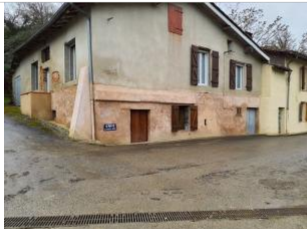
Marque sur structure Photo © AGERIN
