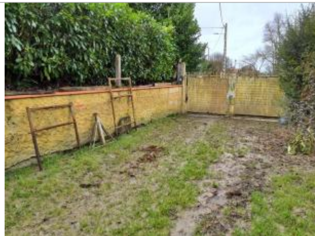
Marque sur structure Photo © AGERIN
