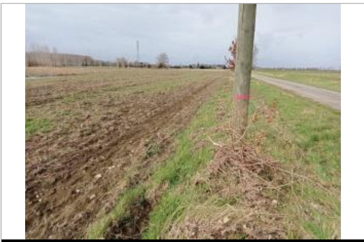
Marque sur poteau électrique Photo © AGERIN
