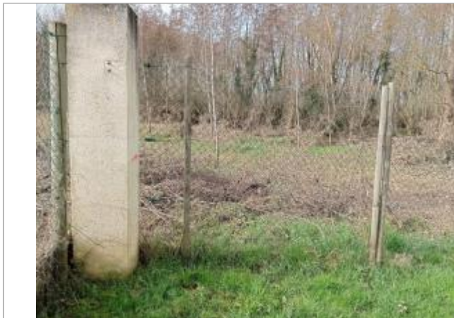
Marque sur structure Photo © AGERIN
