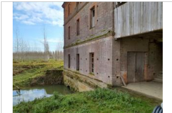
Marque sur structure Photo © AGERIN
