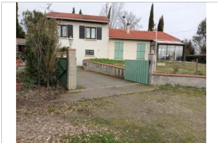
Marque sur structure Photo © AGERIN
