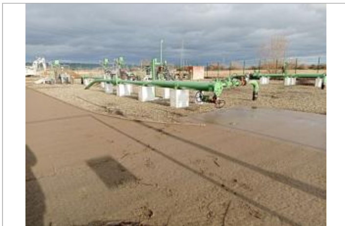
Marque sur structure Photo © AGERIN
