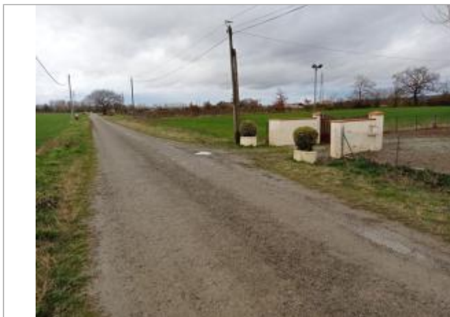
Marque sur structure Photo © AGERIN
