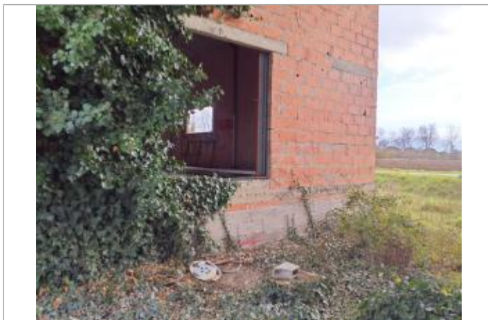
Marque sur structure Photo © AGERIN
