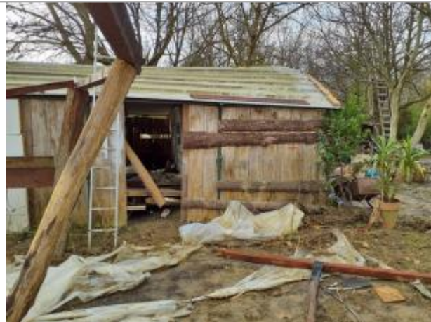
Marque sur structure Photo © AGERIN
