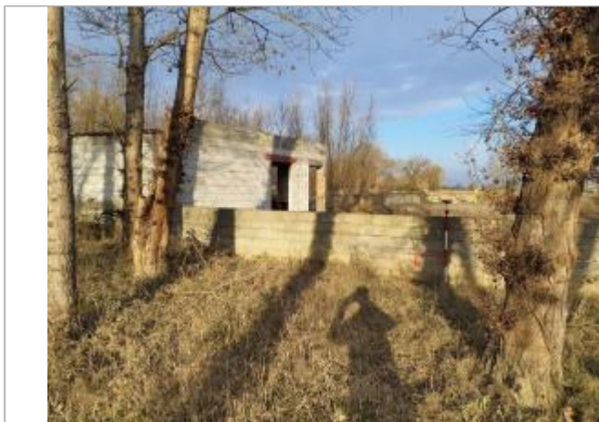
Marque sur structure Photo © AGERIN
