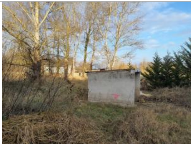
Marque sur structure Photo © AGERIN
