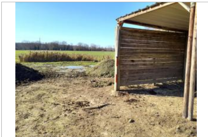
Marque sur structure Photo © AGERIN
