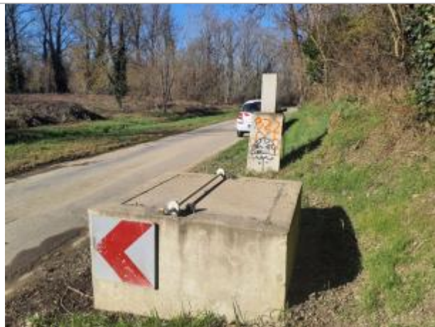
Marque sur structure Photo © AGERIN
