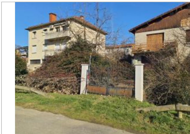
Marque sur structure Photo © AGERIN
