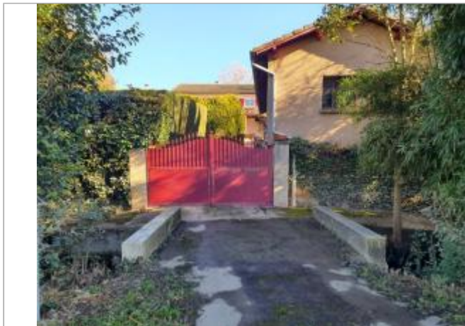
Marque sur structure Photo © AGERIN
