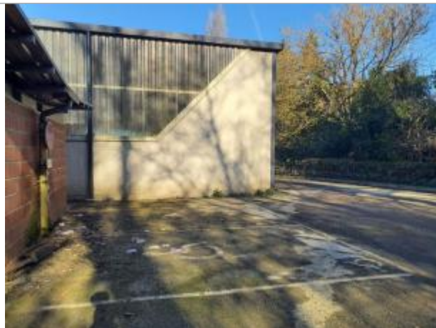
Marque sur structure Photo © AGERIN
