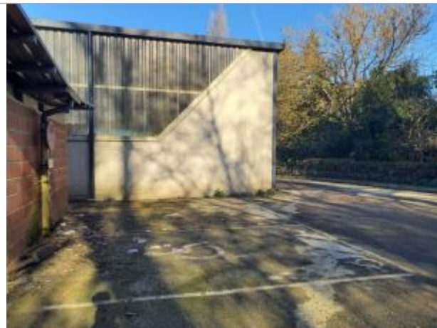
Marque sur structure Photo © AGERIN
