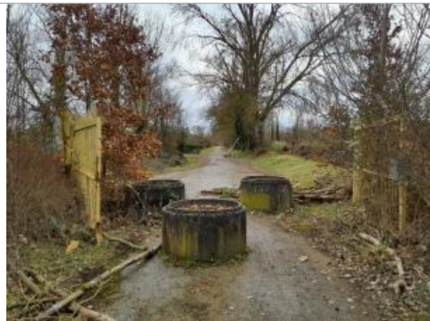
Marque sur structure Photo © AGERIN
