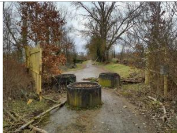
Marque sur structure Photo © AGERIN
