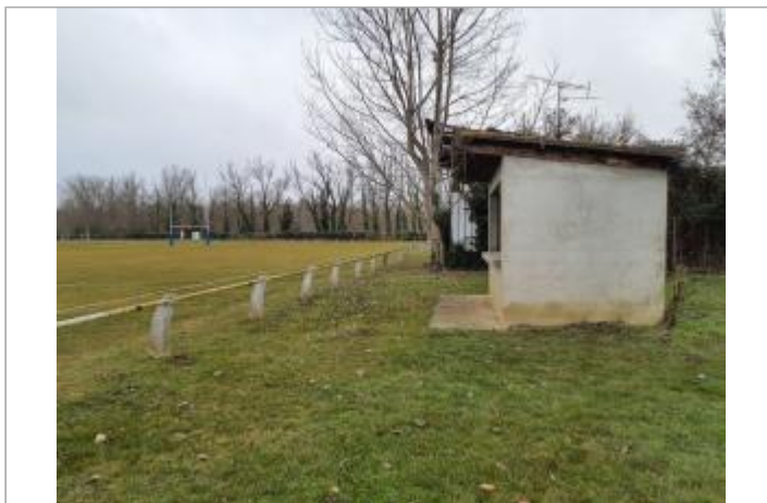
Marque sur structure Photo © AGERIN
