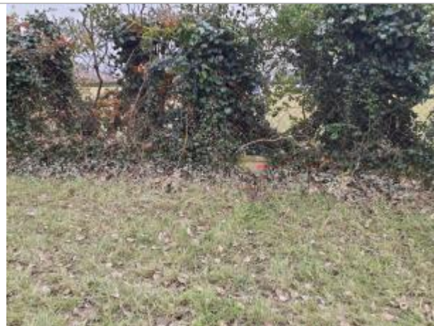
Marque sur structure Photo © AGERIN
