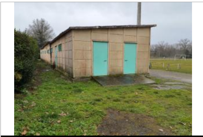
Marque sur structure Photo © AGERIN
